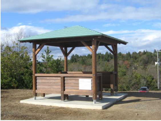
憩いの丘公園に建てられた東屋＝2016年12月
